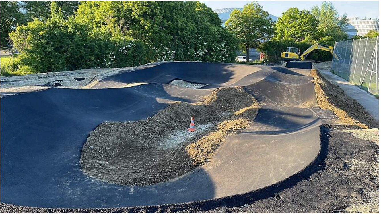
Stand der Arbeiten am Pumptrack am 22. Mai 2026
