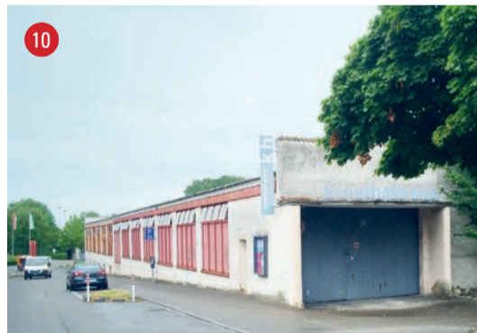
Grabenstrasse 6 Kunsthalle Arbon
